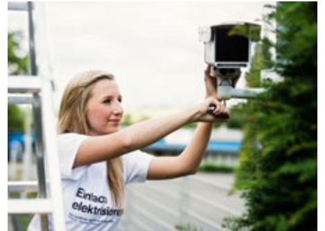
Keine Chance für Eindringlinge: Fixierung und Inbetriebnahme einer Außenüberwachungskamera
