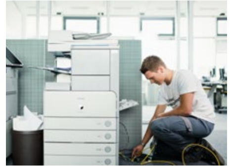
Alles richtig verdrahtet? Channeltest zur Überprüfung der Kabelverbindungen
