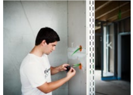
Wichtige Vorarbeiten im Rohbau: Vormontage für einen Schalter und ein Thermostat in einer KNX Installation, erkennbar an den grünen Leitungen.
